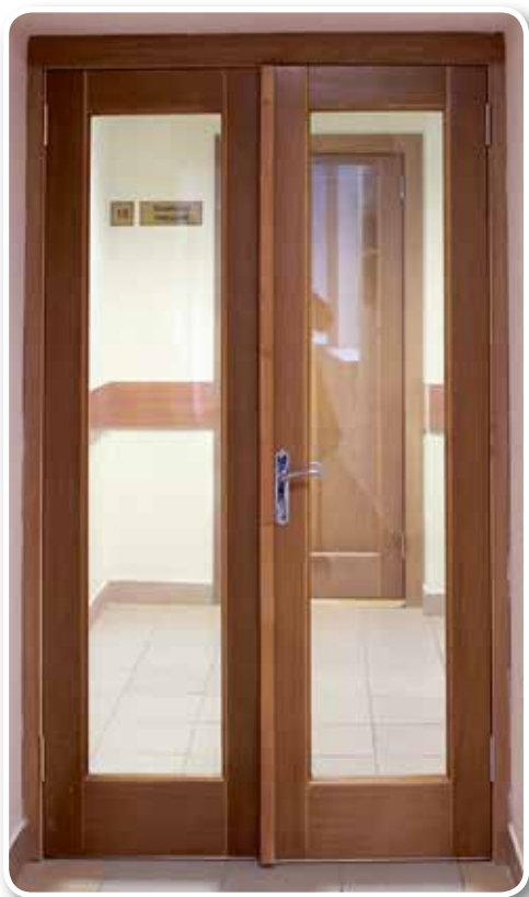
Травмоопасная дверь. Двери со сплошным остеклением не должны использоваться в АПУ.
